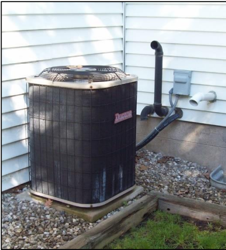
Unité de condensation du climatiseur
